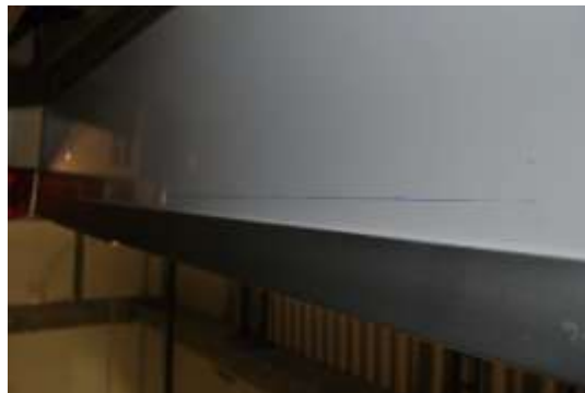
6 Använd hammare för att få vinkeljärnet ligga emot metallisten
