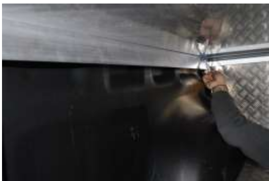
6 Kryp in under modulen och markera vart ni vill ha vinkeljärnet med en penna
