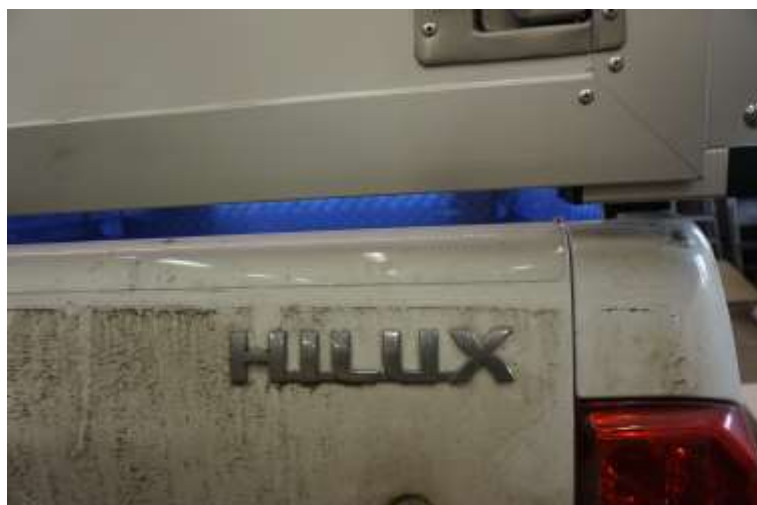
Avsågad balk utan att balken fästs i dörren
