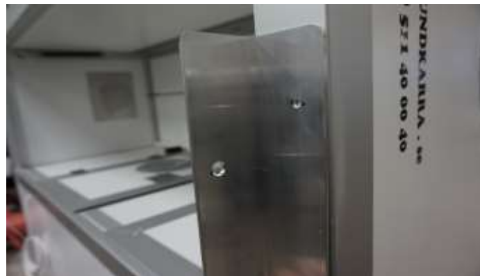
Därefter kan man även förborra in i modulen. Var där bara noga så ni inte borrar rakt igenom modulen.
