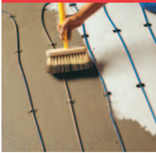
Kabelförläggning
