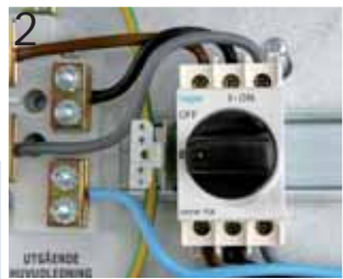
Huvudbrytaren efter mätning
