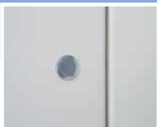
Hål för antenn i dörr
