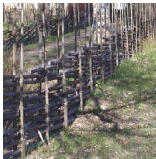
Staket, murar och plank påverkar i allra högsta grad upplevelsen av bebyggda miljöer. Om de gestaltas på ett genomtänkt sätt kan det tillför de arkitektoniska värden och bidra till öppna och inbjudande platser.
