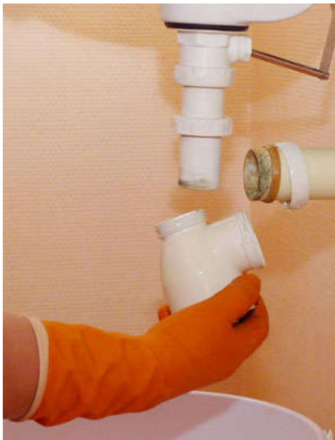
När ringarna är lossade tar du vattenlåset och böjer det nedåt tills det släpper från det övre röret. Sedan drar du ut vattenlåset från sidoröret.
