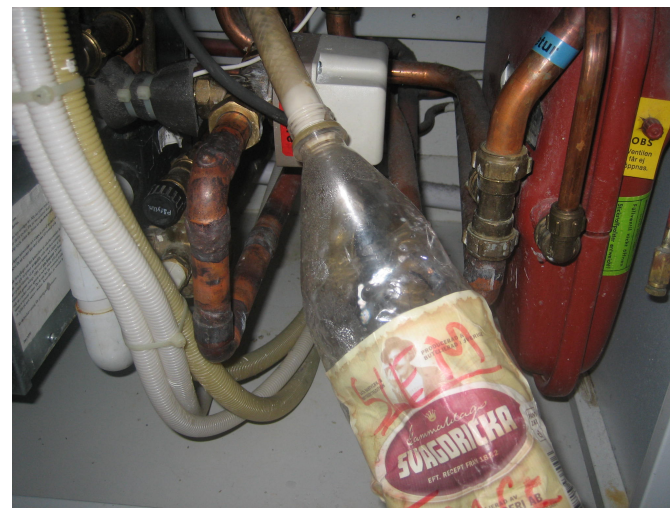
Bild 3 (vattenfylld PET flaska klar för att spola ren slangens)
