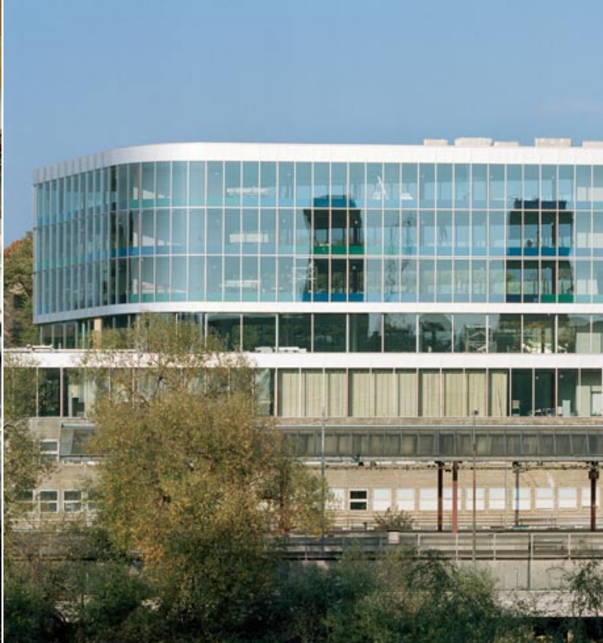
Bonnierhuset har sGG CLIMAPLUS EGLAS i konsthallens tak för att undvika kallras. Arkitekt: Johan Celsing
