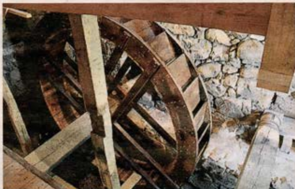
Det stora kvarnhjulet i Vattenmöllan kom på plats i våras. Det har byggts efter gamla dokument från 1700-talet.
