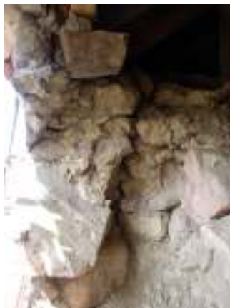
Skalmurad vägg med grova stenar i ytterliv och mindre stenar lagda i lerbruk i murens kärna. Den norra respektive södra murposten under uppmurande
