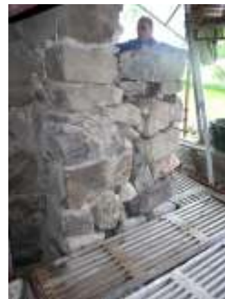
Skalmurad vägg med grova stenar i ytterliv och mindre stenar lagda i lerbruk i murens kärna. Den norra respektive södra murposten under uppmurande
