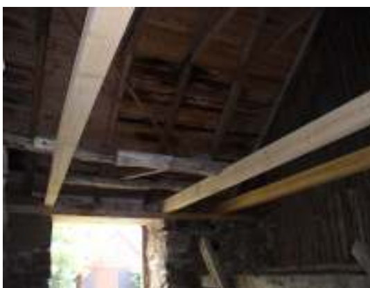
De tre ramsågade bindbjälkarna har kommit på plats i ursprungliga urtag i muren. Bindbjälkarna disponerade ovan remstycke av ek och fästade mot takstolen med järnband
