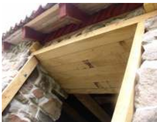
Remstycke av ek samt bindbjälkar av furu utlagda. Portstolpar av ek fastbultade i muren. Överliggare av ek utlagda på urtag på murens ovsida.
