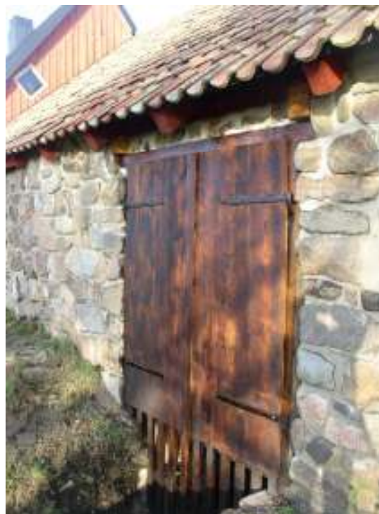
Den norra dörrposten. Kvarnrännan dränerar kvarnens inre på vatten. Den nya porten av spontade furubräder behandlades med trätjära
