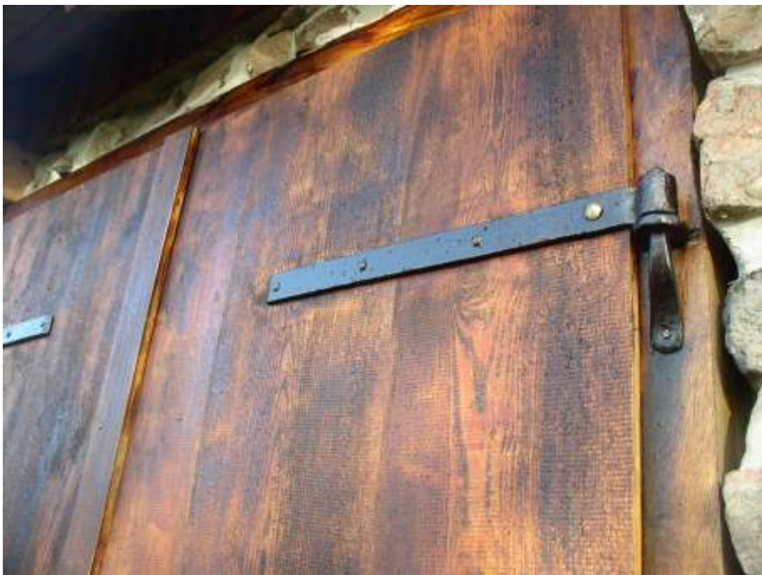
Ny port av breda ramsågade och spontade furubröder. De gamla gångjärnen och beslagen behandlade med linoljefärg
