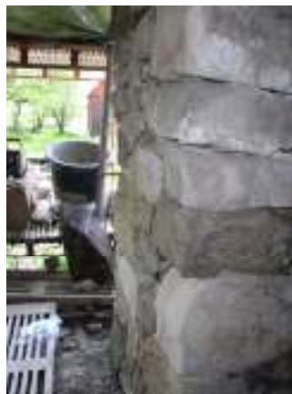
Skalmurad vägg med grova stenar i ytterliv och mindre stenar lagda i lerbruk i murens kärna. Den norra respektive södra murposten under uppmurande
