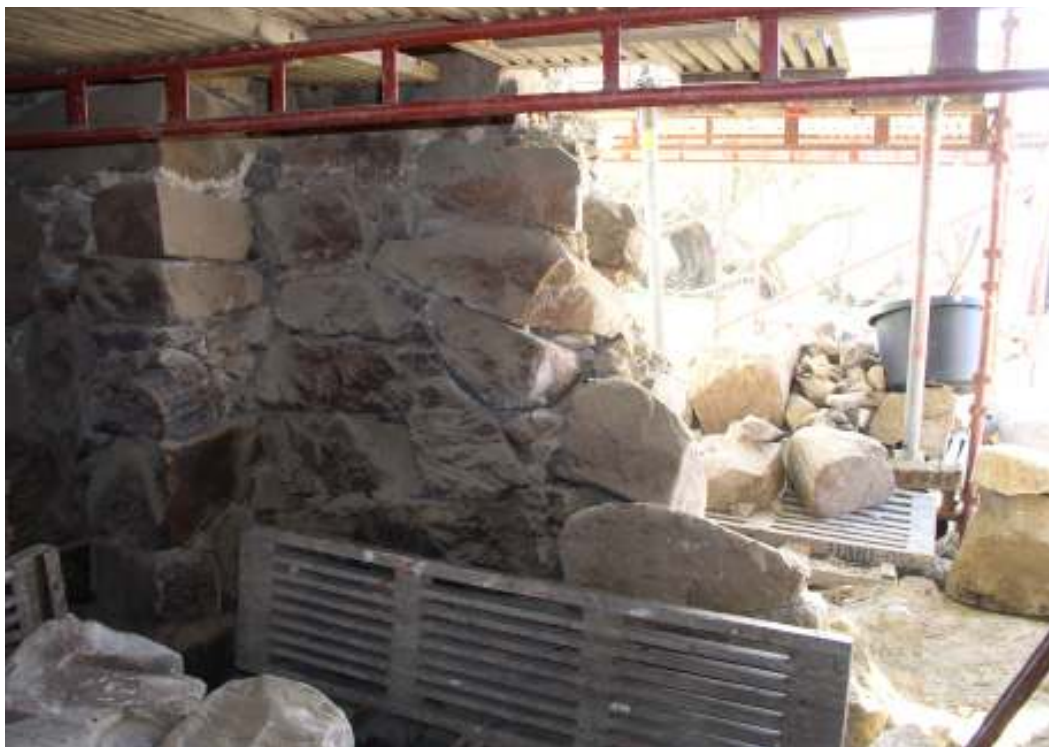
Murverket från insidan under rivning
