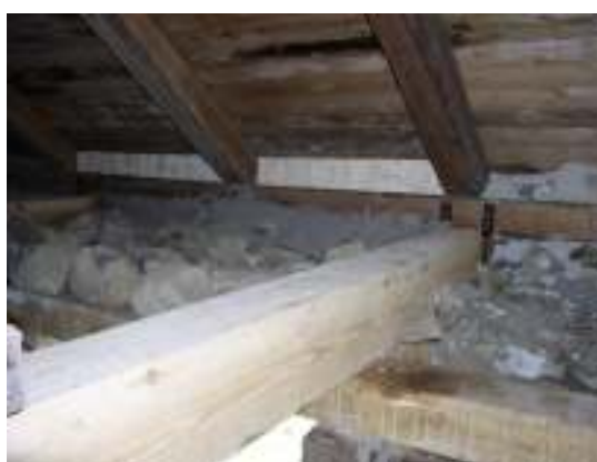
De tre ramsågade bindbjälkarna har kommit på plats i ursprungliga urtag i muren. Bindbjälkarna disponerade ovan remstycke av ek och fästade mot takstolen med järnband
