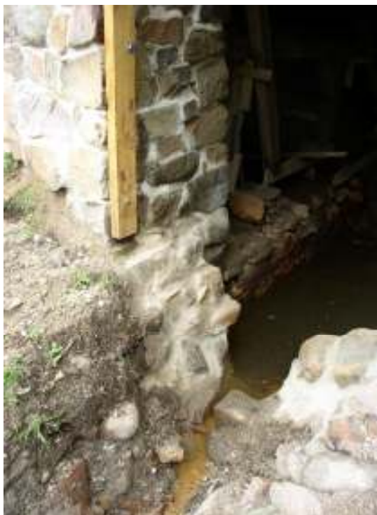
Den norra dörrposten. Kvarnrännan dränerar kvarnens inre på vatten. Den nya porten av spontade furubräder behandlades med trätjära
