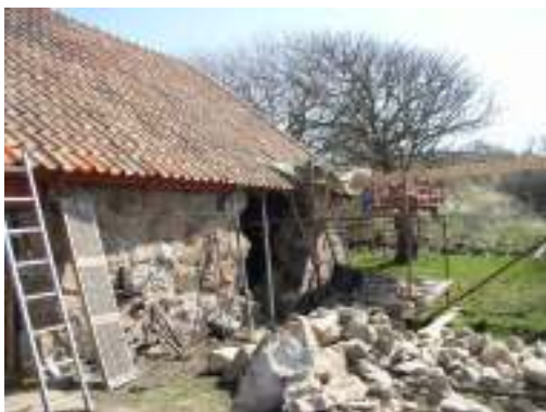
Taket uppstämplat och delar av murverket rivet. Ramsågade furubjälkar inskjutna under taket
