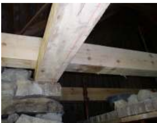
Remstycke av ek samt bindbjälkar av furu utlagda. Portstolpar av ek fastbultade i muren. Överliggare av ek utlagda på urtag på murens ovsida.
