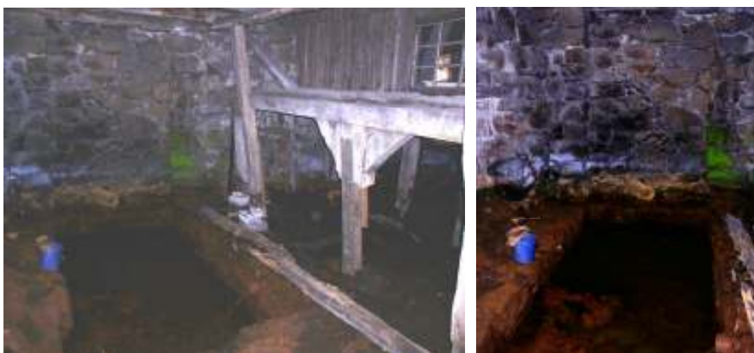
Kvarnens insida, hjulgraven mot västra väggen. Kvarnstolen av ek från 1700-talet bevarad. Den igenmurade öppningen med tunnare mur tydligt läsbar i murverket
