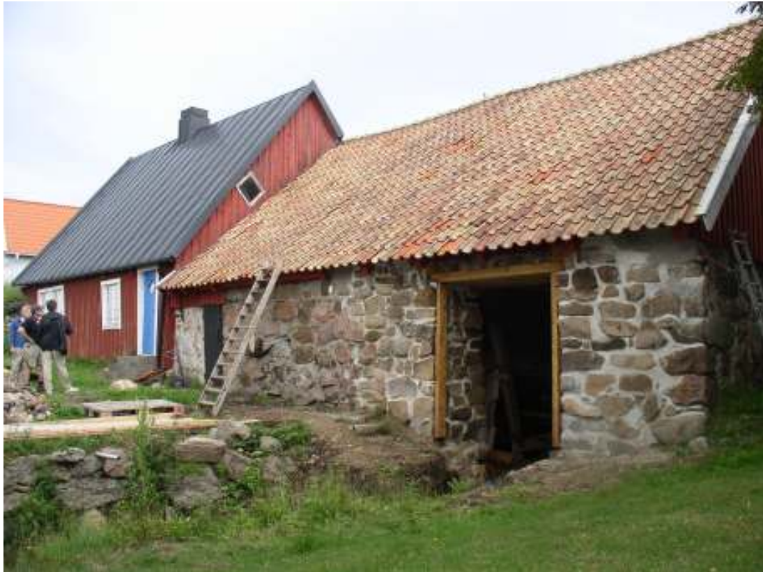
Den västra väggen lagad samt rekonstruerad portöppning
