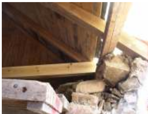
Taket uppstämplat och delar av murverket rivet. Ramsågade furubjälkar inskjutna under taket
