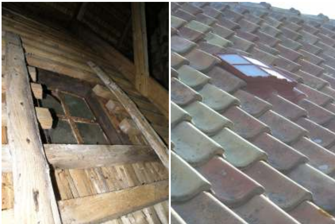
Detalj av takfönstret, sett inifrån kvarnloftet.
