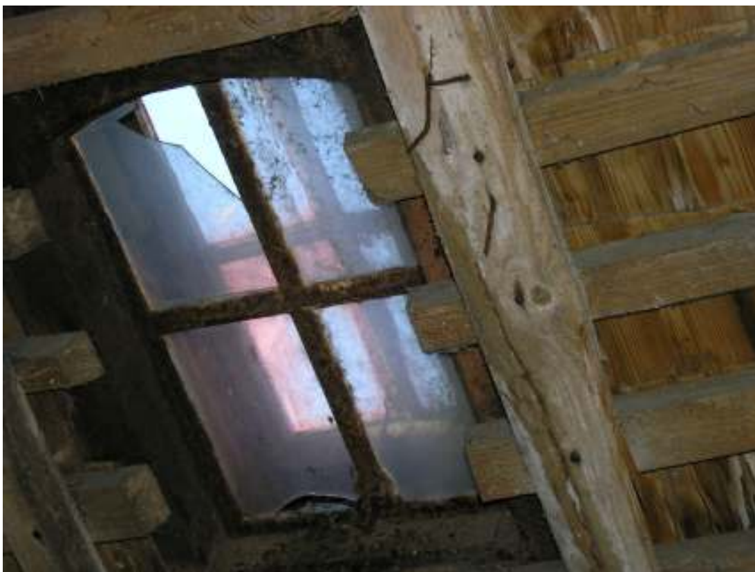
Kvarnloftets takfönster har återfått sin ursprungsfunktion tack vare det takfönster (också det i gjutjärn) som, i samband med takomläggningen, har satts in i tegeltaket. Foto: Werner Leyb
