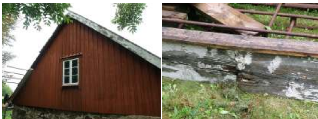
Vattenmöllans södra gavel under åtgärder med vindskivan. Detalj av nedplockad vindskiva och vattbräda.
