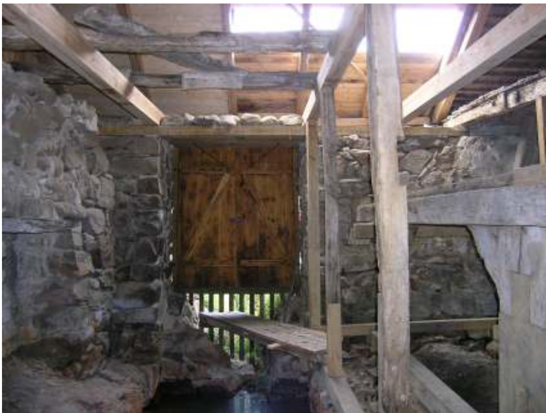
Pågående takomläggning sedd inifrån Vattenmöllans kvarnhus.
