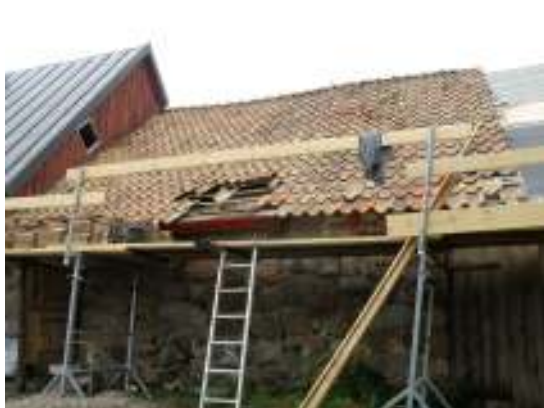
Omläggning av västra takfallets norra del.
