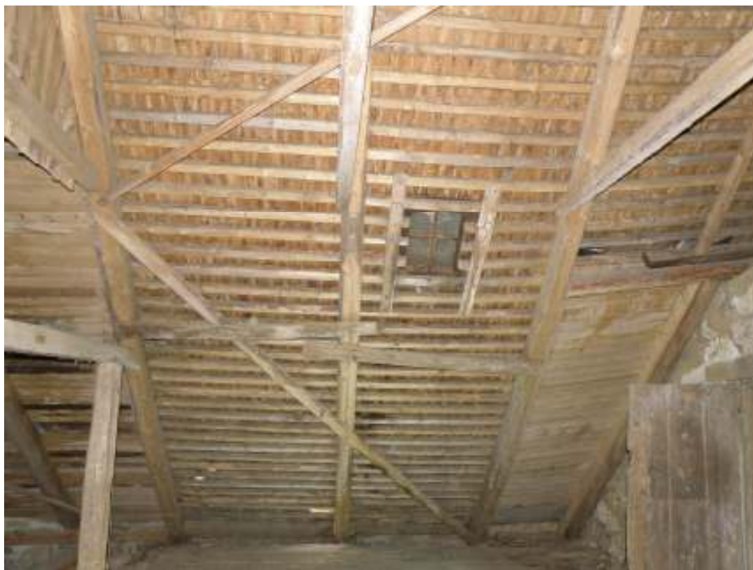
Vy över kvarnloftets spåntak med vindsfönster i gjutjärn. Då bilden togs var ännu takfönstret täckt av tegelpannor.
