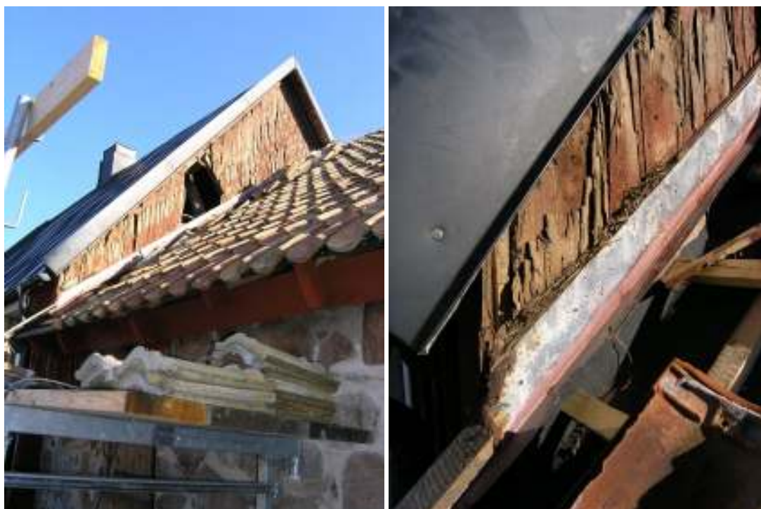
Under boningsdelens brädklädda gavel fann man stickor. Detalj av stickorna. Vid plåten syns även rester av ett stråtak.
