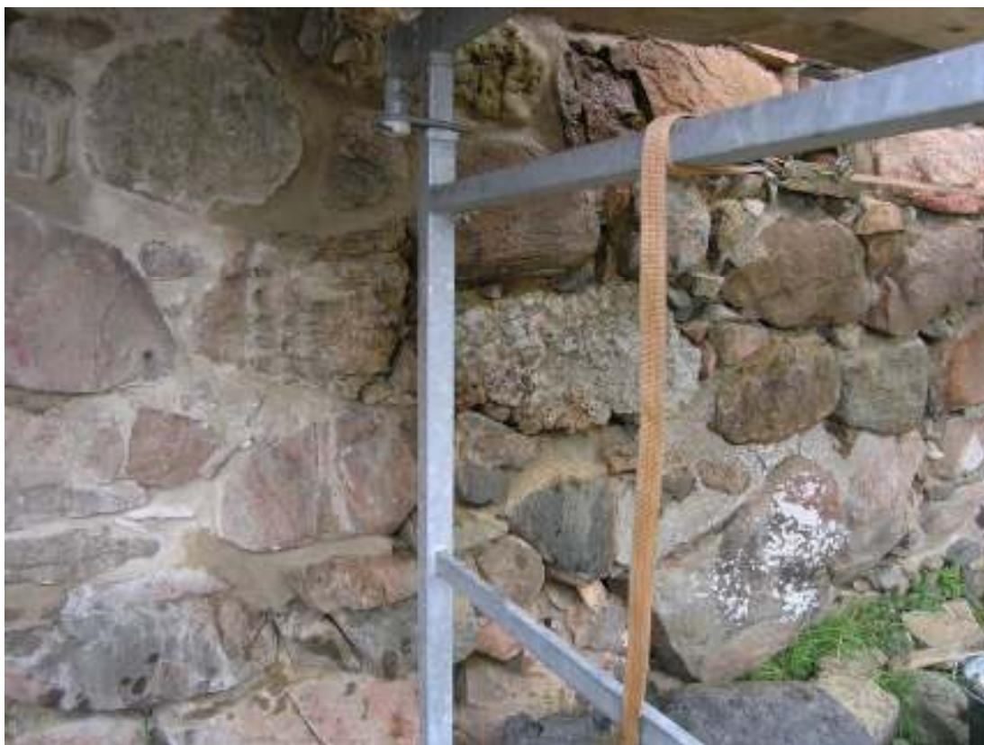
Pågående fogningsarbete av Vattenmöllans västra sockel.
