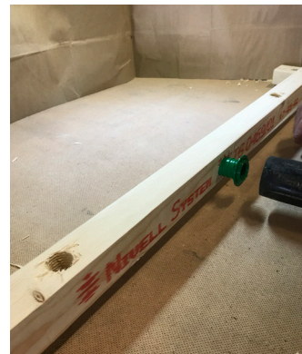
Borring av tvärställt hål för montering av gänghylsa och stöd mot vägg.
