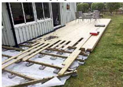
Exempel på montage på gräsmatta med fiberduk
