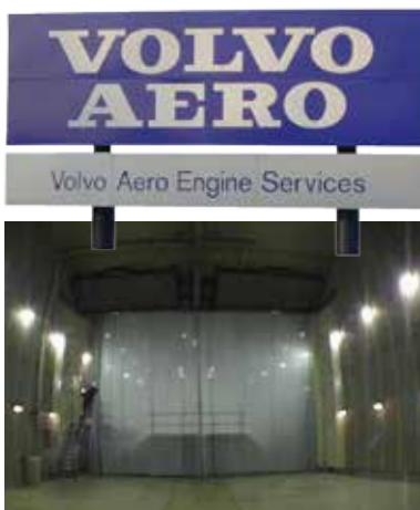
Decor-Cem® ytbehandlad 1963. Lintaverken, Testhall för Jetmotorer, Provcell 3, Bromma. (Intakt 53 år senare)
