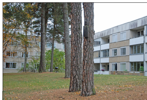
Fig. 37. Lamellhus vid Logdansvägen. Foto: Rolf Ham-mar-skiöld.
