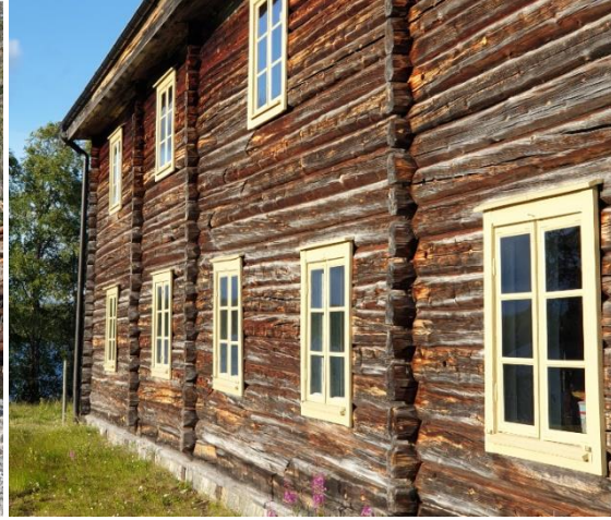
Renoverade fönster i
