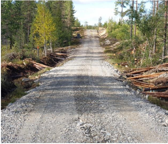
Nyrenoverad väg Gammelhuset
