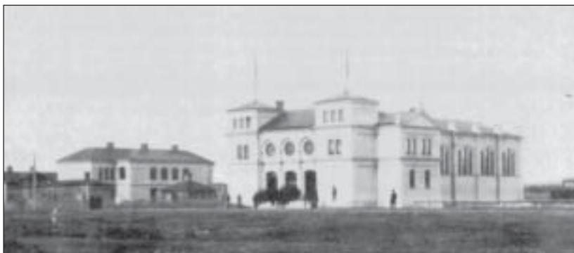
Läroverkets gymnastikhus vid Skolgatans norra sida. Foto från 1890-talet. VMU. Umeå stadsbyggnadshistoria 1621-1895.
