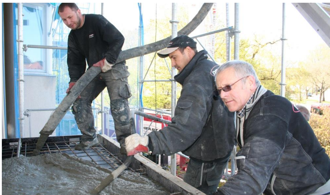
En av många balkonggjutningar under 2013.
