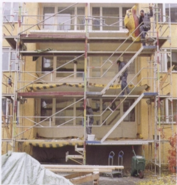
Dipart håller på med en balkongentreprenad i Jakobsberg - ett 80-tal balkonger som fördjupas 600 mm.
