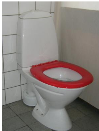
Bild på förstärkta fästen.
