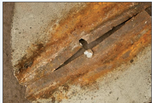
Bakskärm på Seat Ibiza -02 med bristfälligt skydd av spaltytorna
