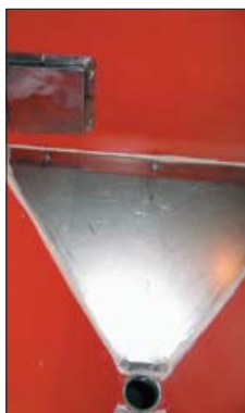
Bottenplåtar på plats och kåpa över spjällets insläpp.
