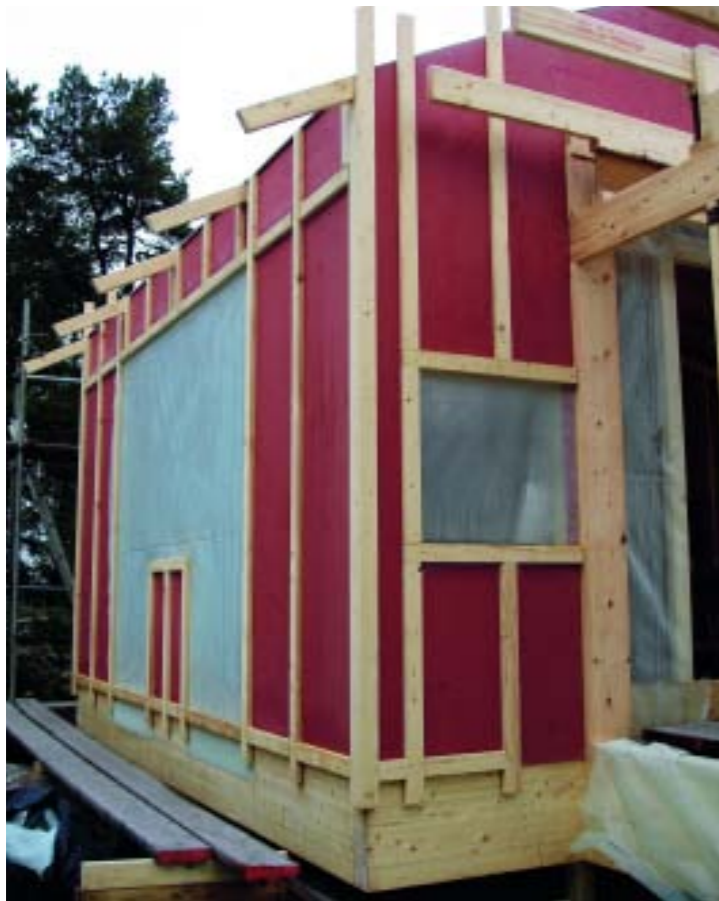
Väggen läktas för att så småningom kläs in med panel.
