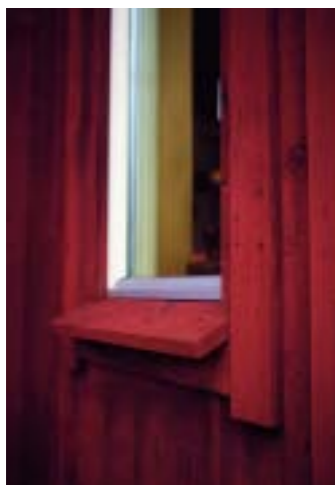
En träfasad fungerar bäst om den bara består av trä. För att undvika fuktskador orsakade av kondens har Bengt därför använt trä även till »fönsterblecken«.
