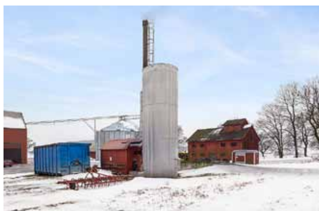
En halmpanna förser svinhus, personalutrymmen, verkstad, potatislager och bostäder med värme. Foto: Diakrit.
