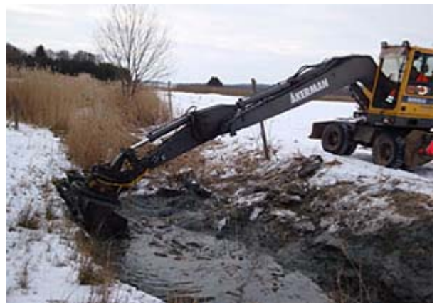
Grävning av sedimentdike för minskad fosforbelastning till vattenmiljön.
