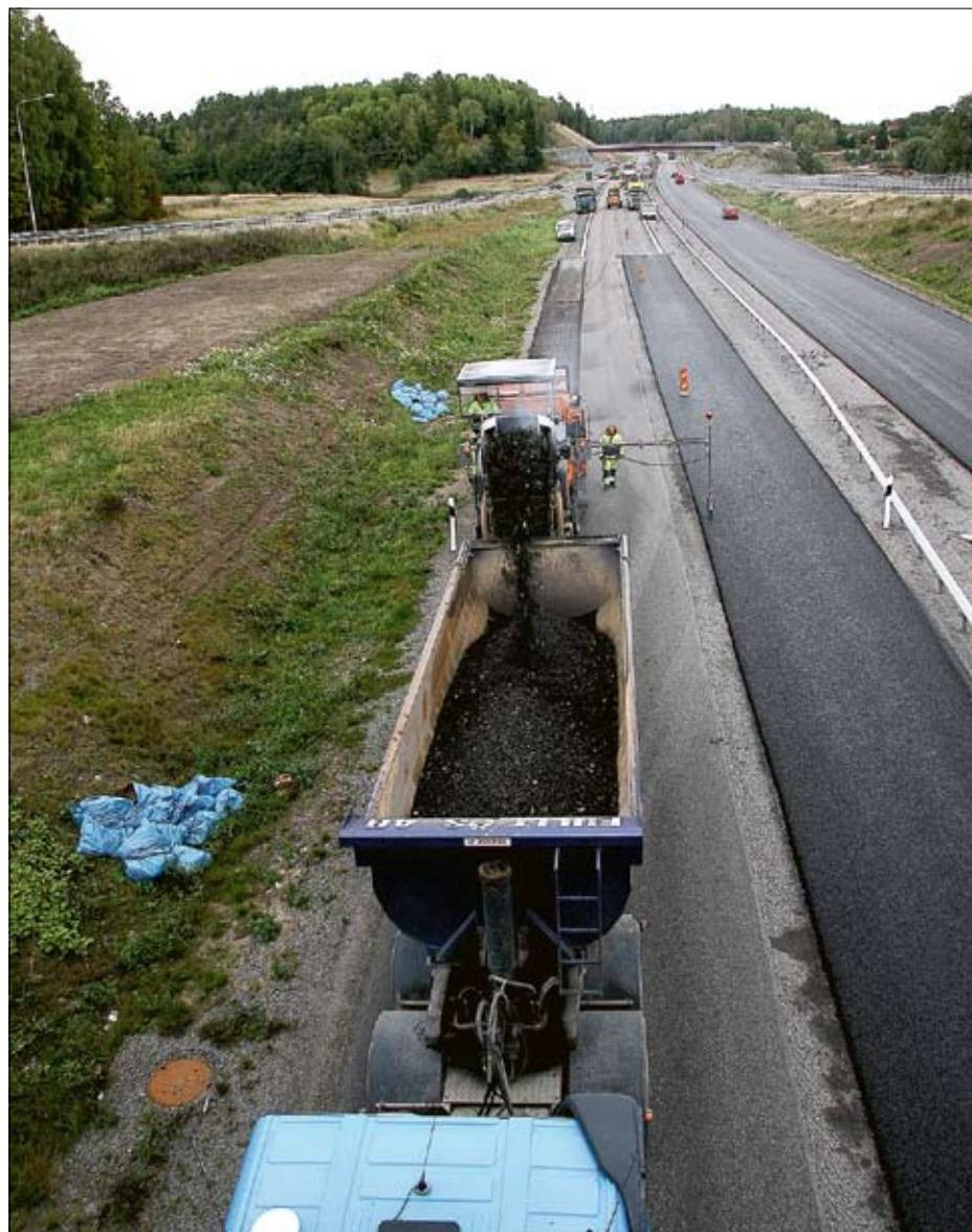
Nerfräst. Asfalten på den ojämna sträckan vid Överfors är omlagd och den nya asfalttoppen ligger slät och svart. FOTO: ANDERS LÖFGREN
